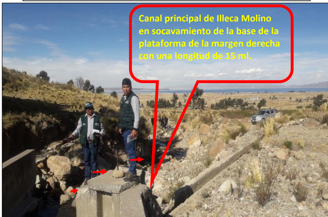
FIGURA N°02: TALUD DE LA QUEBRADA COLAPSADO Y EL CANAL DE LA MARGEN DERECHA ESTA A PUNTO DE COLAPSAR Y LOS USUARIOS DEL COMITE DE AGUA DE RIEGO QUEDE SIN RECURSO HIDRICO
